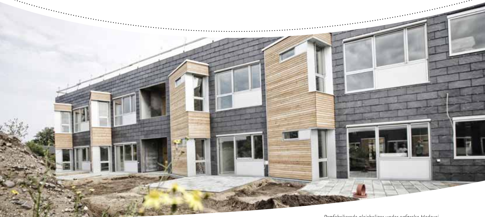
Præfabrikerede plejeboliger under opførelse Hedevej.
