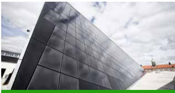
Solceller Kulturproduktionscenter Godsbanen.
