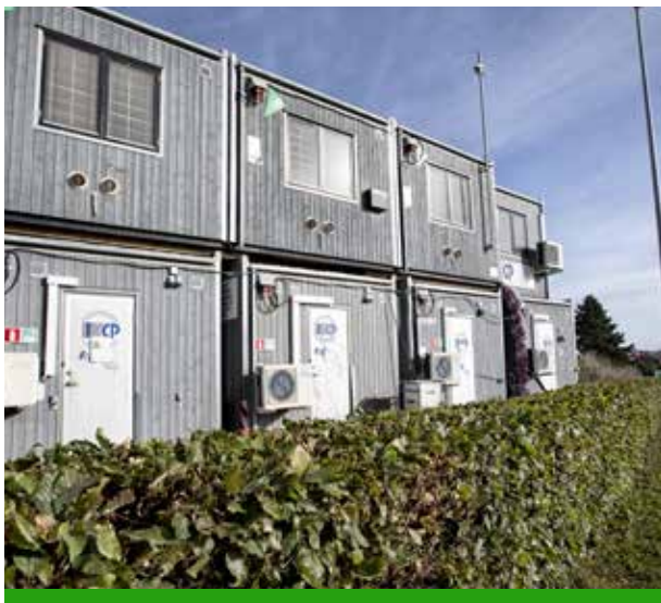
Byggepladsskure med luft til luftvarmepumper og energistyring.
